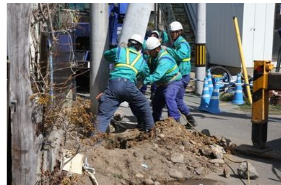
配電設備の復旧作業③(宮城県仙台市)
