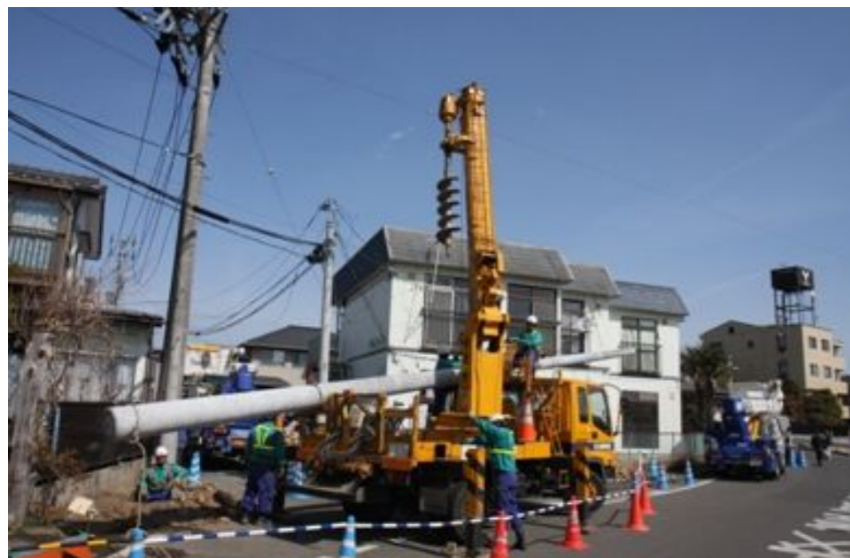
配電設備の地震による復旧作業①(宮城県仙台市)
