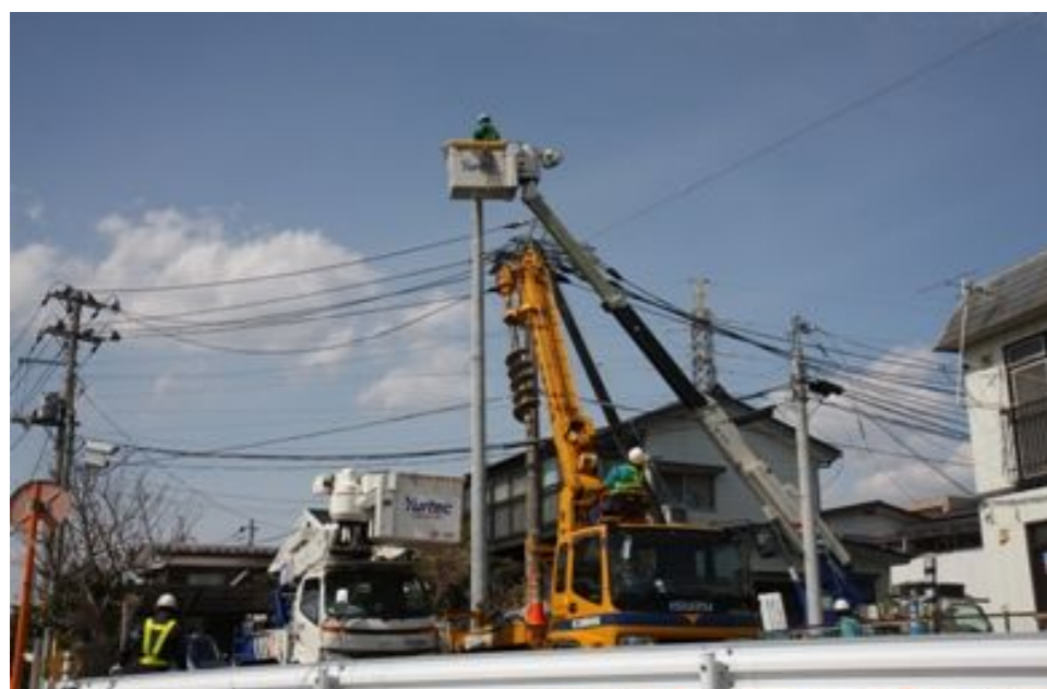
配電設備の復旧作業④(宮城県仙台市)
