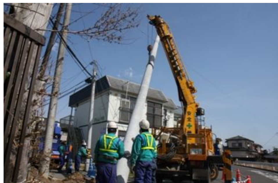
配電設備の復旧作業②(宮城県仙台市)
