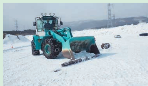
散乱したがれきをホイールローダで除去 (2月28日)
