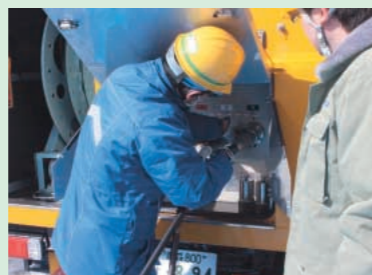
電源車にケーブルを接続
