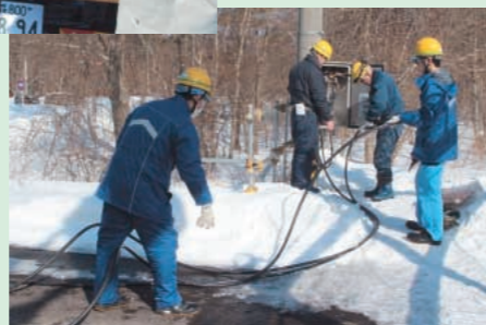
電源車からのケーブルを配電線へ接続
