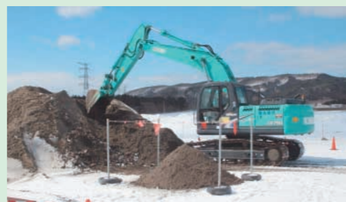
堆積した土砂をバックホウで除去 (3月7日)
