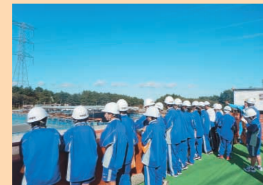
安全対策工事の現場見学（淡水貯水槽）
