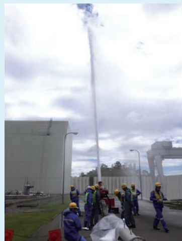
放水試験の様子
