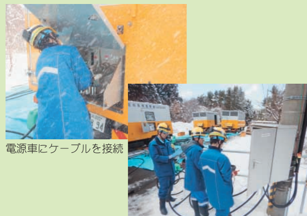
電柱にケーブルを接続(3月8日)
