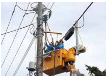
高所作業車による接続作業
