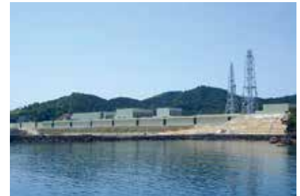
防潮堤のかさ上げ工事を行っている 女川原子力発電所
