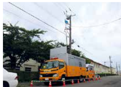
高圧電源車による応急送電
