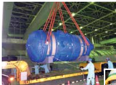
原子炉格納容器圧力逃がし装置（フィルタベント系）*の搬入作業（女川原子力発電所）
