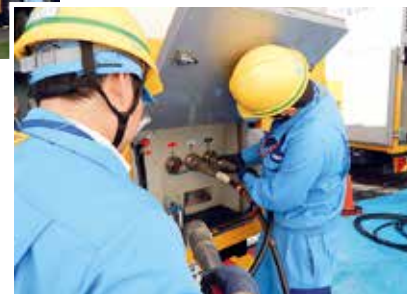
原子炉建屋に電気を送るための電源車の接続訓練（東通原子力発電所）
