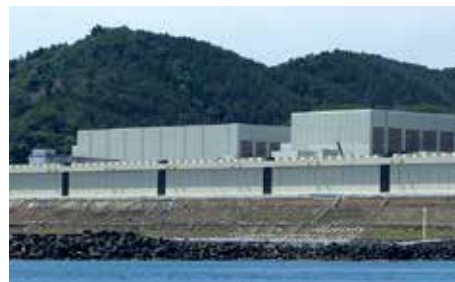
海拔約29m、全長800mにおよぶ 防潮堤かさ上げ工事（女川原子力発電所）
