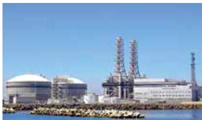
新仙台火力発電所
