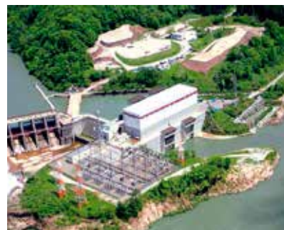
鹿瀬発電所（新潟県東蒲原郡阿賀町）
