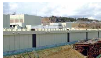
海拔約29mの防潮堤かさ上げ工事(女川)
