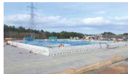
淡水貯水槽設置工事(東通)
