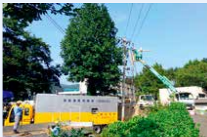
高所作業車を使用した復旧作業
