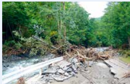
河川氾濫の影響により倒壊した電柱
