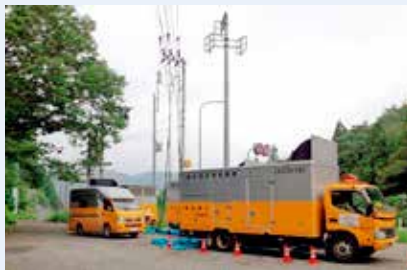
高圧発電機車による送電
