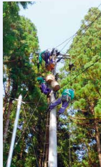
昇柱による復旧作業
