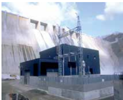
津軽発電所(青森県中津軽郡)
