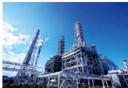
世界最高水準の熱効率を達成した 新仙台火力発電所 3号系列
