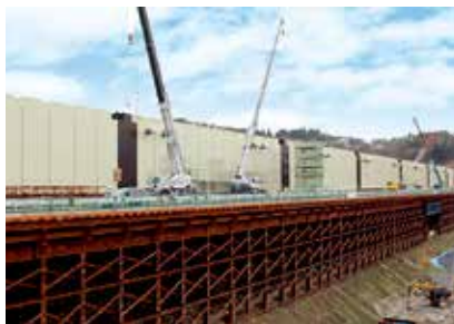
海拔約 29m の防潮堤かさ上げ工事 (女川原子力発電所)
