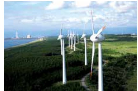
本州初のウインドファーム（集合型風力発電所）である能代風力発電所（秋田県能代市）
