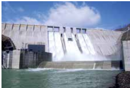
今年5月に営業運転を開始した津軽発電所 （青森県中津軽郡）
