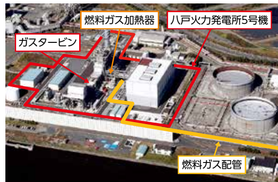
八戸火力発電所5号機の外観
