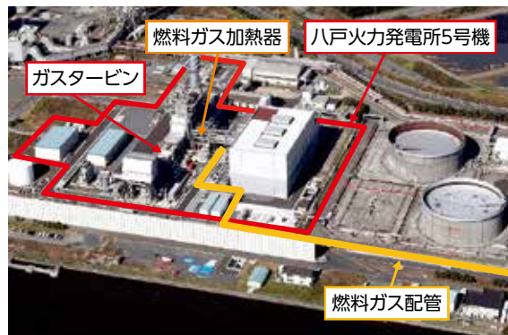
八戸火力発電所5号機の外観
