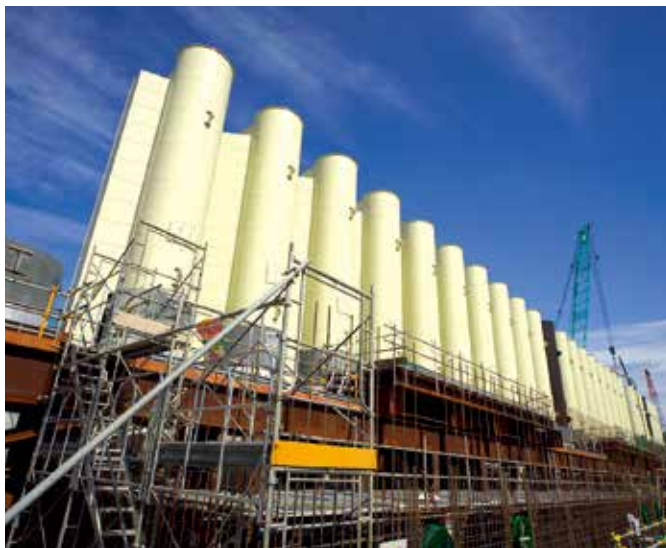
女川原子力発電所の防潮堤かさ上げ工事
