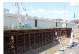
防潮堤かさ上げ工事(女川)
