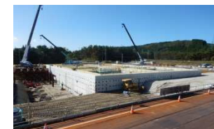
淡水貯水槽設置工事(東通)
