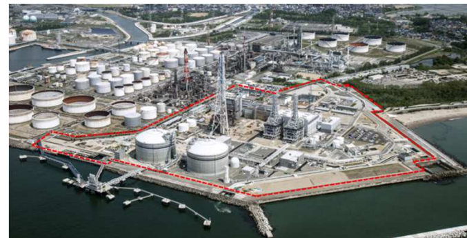
【新仙台火力発電所】
