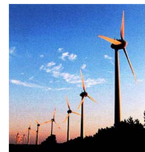
当社グループ企業 東北自然エネルギー開発(株) 能代風力発電所(14,400kW)
