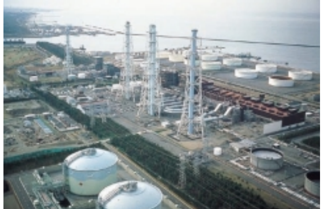
東新潟火力発電所4-1号系列
