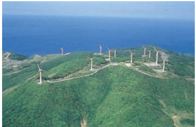
竜飛ウィンドパーク(風力発電実証試験設備)
