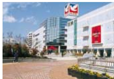
仙台泉中央熱供給センター(入居ビル外観)
