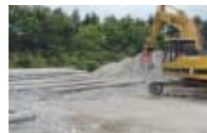
古コンクリート柱中間処理
