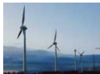
能代風力発電所
