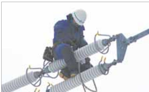
がいしの清掃作業は困難を極めた
