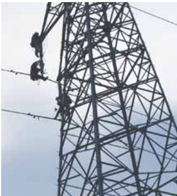
悪天候の中、復旧作業が続けられた
