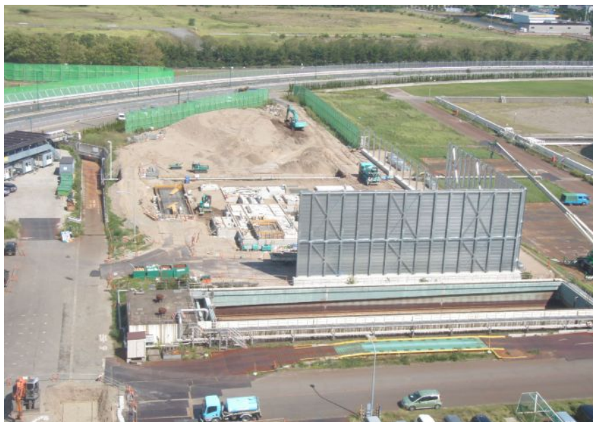
設置工事の状況（平成23年9月7日撮影）
