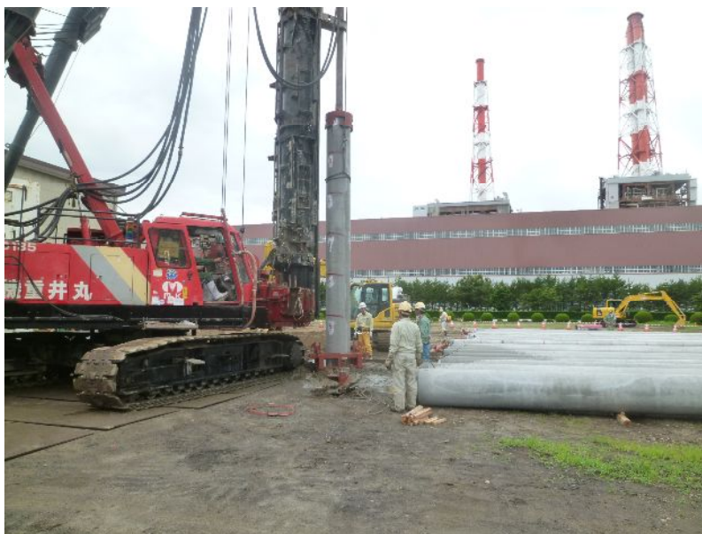
ガスタービン基礎部杭打設工事（平成 23 年 9 月 6 日撮影）
