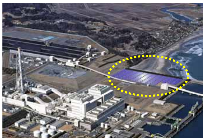
原町太陽光発電所
